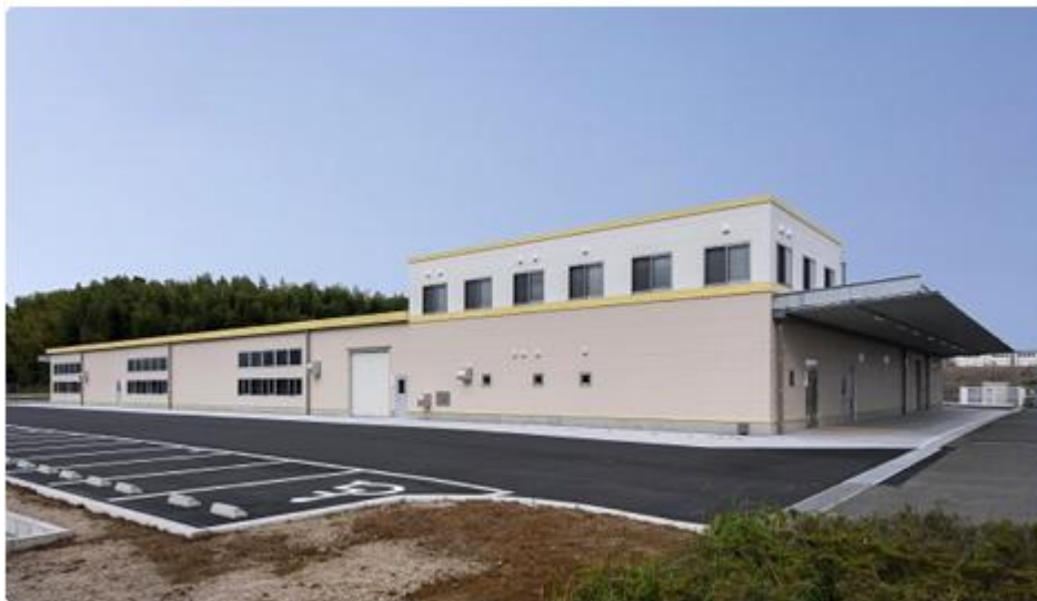
完成した第2工場
