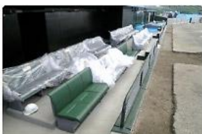
現地工事中風景
